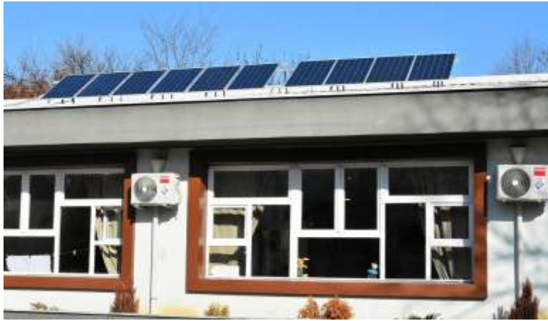
Слика38. Хибридни колектори на градинката „Мајски Цвет“ – објект „Јасмин“
