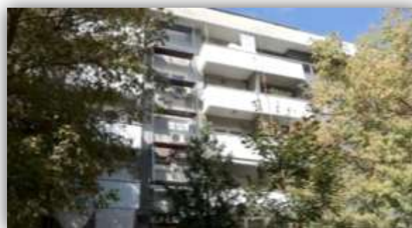
Слика 32. Термоизолација на фасади на објекти за колективно домување
