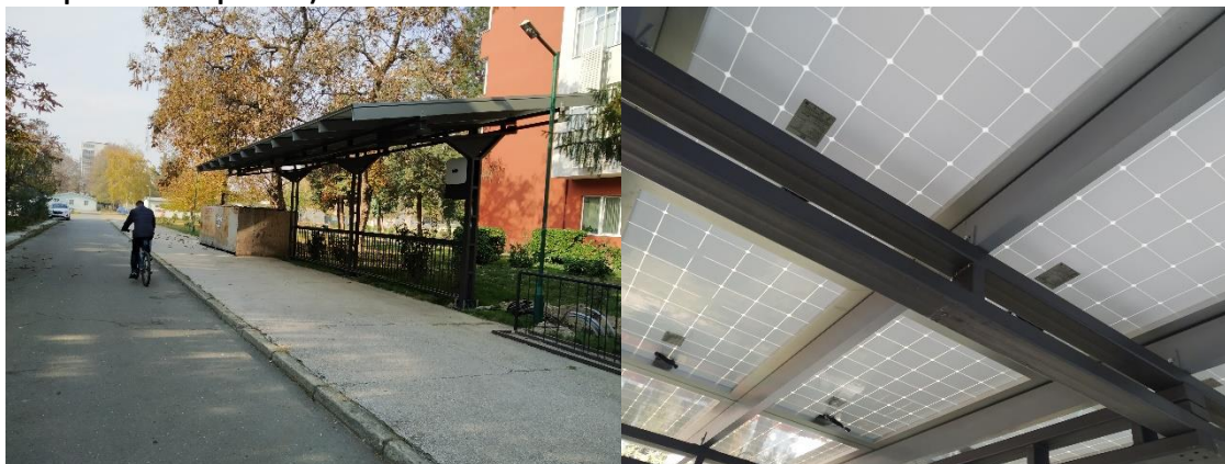
Слика 13 - Паркинг простор во рамките на проектот FV-PAM (ФВ модул со интегрирани батерии и контролна електроника) 7
